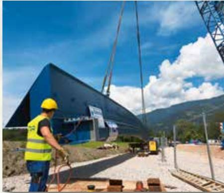
war aufgrund der Aufweitung des Flussbettes erforderlich und hat zu einer wesentlichen Qualitätsverbesserung geführt. Die neue Brücke wurde circa 25 m flussaufwärts als 2-spurige Stahltrögbrücke errichtet.
