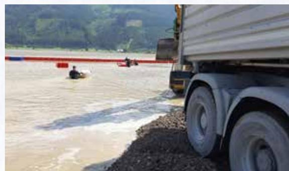
Ein neuer Damm musste errichtet werden. Wasserretter bauten dazu einen Behelfsdamm mit mobilen Hochwasserelementen im metertiefen Wasser.
