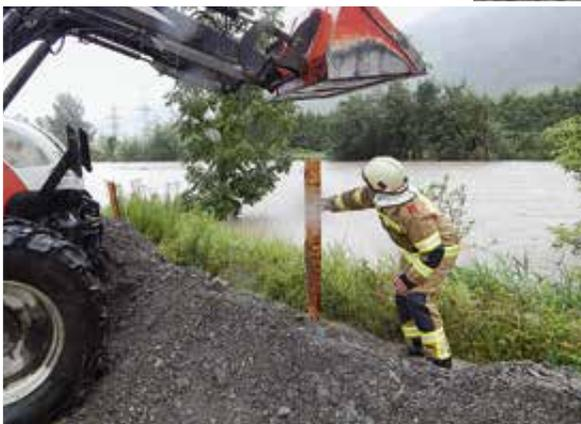
Freiwillige Feuerwehr Bruck, in Abstimmung mit der BH Zell am See, über eine Länge von ca. 150 m ein Erdamm errichtet. Ohne diesen Damm wäre in den Mittagsstunden dieser Bereich überflutet worden.
