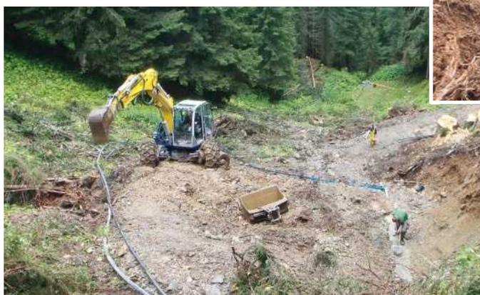
Waxeckquelle: Quellfassungsarbeiten - Grabungsarbeiten
