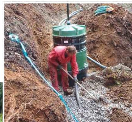
Einbau eines Quellsammelschachtes
